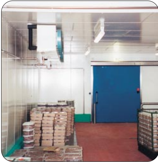
Magasin de stockage de produits d'épicerie fine entièrement équipé de panneaux isolants RFV d'ECP.
